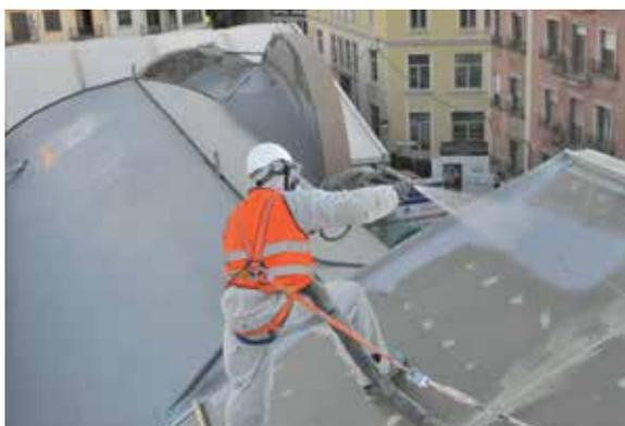
Apto para la impermeabilización de cubiertas empleando membranas de poliuretano de aplicación en líquido, proyectadas y manuales; que permiten su uso en cubiertas con dificultades de acceso o con un gran número de recortes y entregas.
